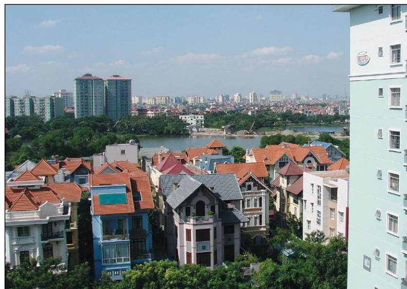
Foto 1: Wohnanlage Linh Dam im Süden Hanois. Im Hintergrund sind Bauarbeiten für die 3. Ringstraße zu sehen
