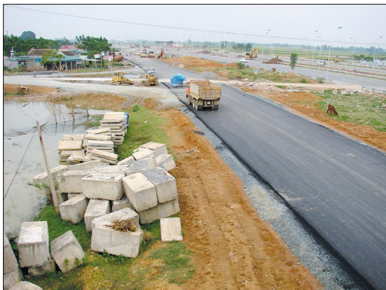
Foto 3: Der 2009 noch im Bau befindliche Thang Long Highway stellt die zentrale Entwicklungsachse im Westen Hanois dar.
